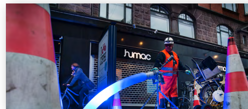
© Ines Knaack/Aarsleff Rohrsanierung GmbH
