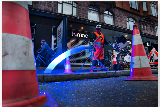
© Ines Knaack/Aarsleff Rohrsanierung GmbH
